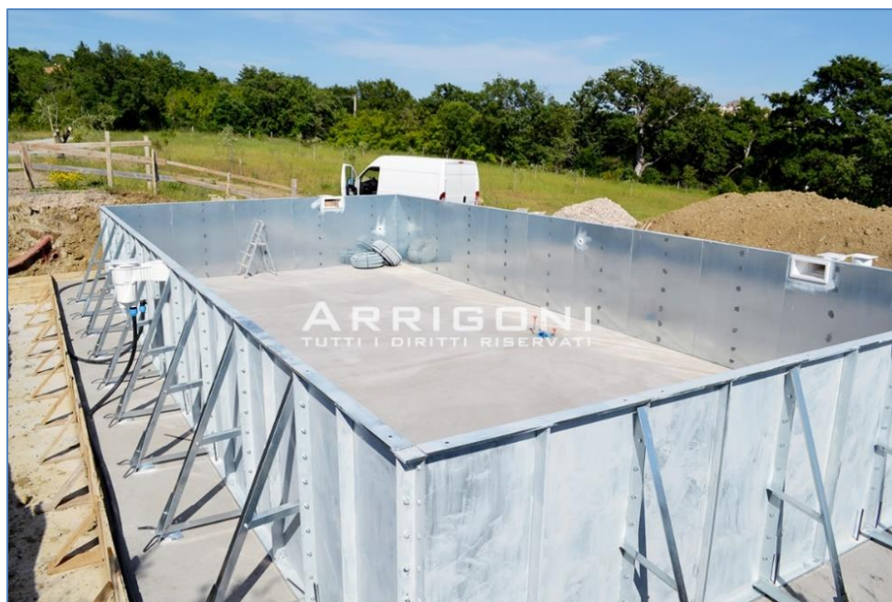
Piscina realizzata nei pressi di Manciano (Grosseto)
